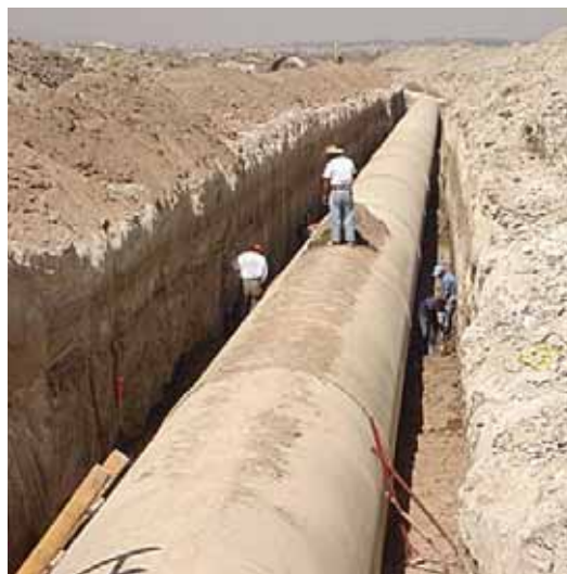
Proceso de Instalación
