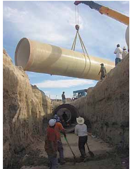
Colocación de la Tubería FLOWTITE de P.R.F.V. en zanja.
