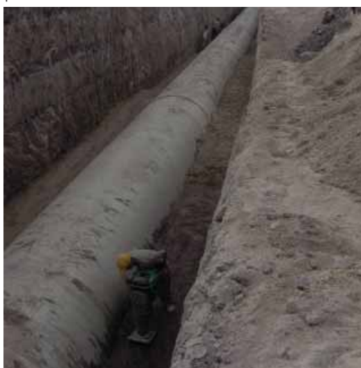
Proceso de Compactación
