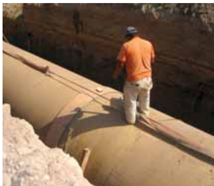
Para el acoplamiento de tuberías se utilizaron bandas teladas y polipastos.
