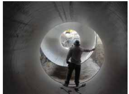
Control de colocación y alineamiento interno.
