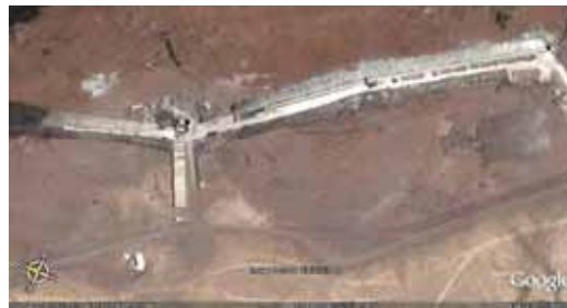
Imagen de satélite de la Tubería FLOWTITE de P.R.F.V. , al costado de una de las zanjas. Al lado (en color verdoso) acumulación de aguas residuales.
