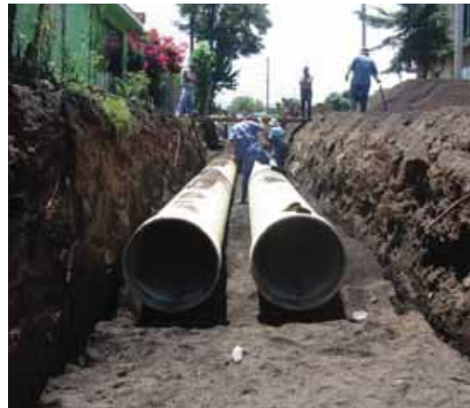
Dos tubos de DN 750 mm. en paralelo
