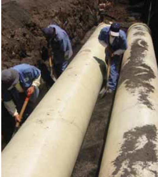
Colocación del material de relleno
