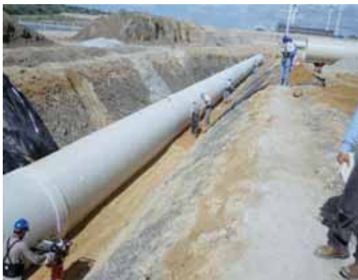
Labores de compactación
