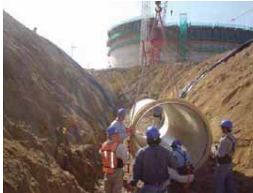
Instalación en plataforma
