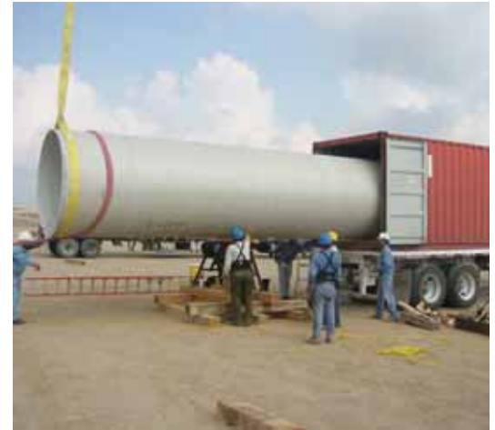
Descarga de la tubería del contenedor
