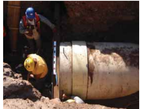
Colocación del tapón con atraques de vigueta metálica
