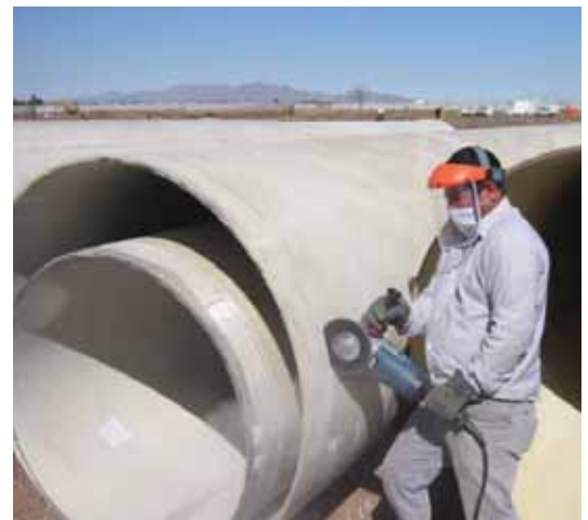
Corte de la tubería
