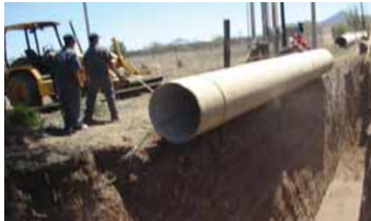
Bajada a la zanja de tubería sin Grúa
