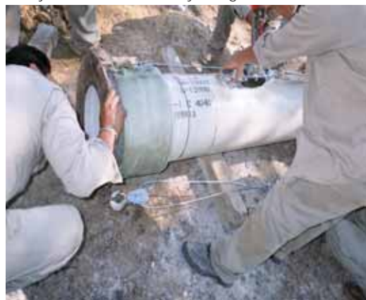
Colocación de coples en el tubo PRFV
