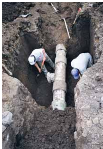
Instalación de Tees para desagüe
