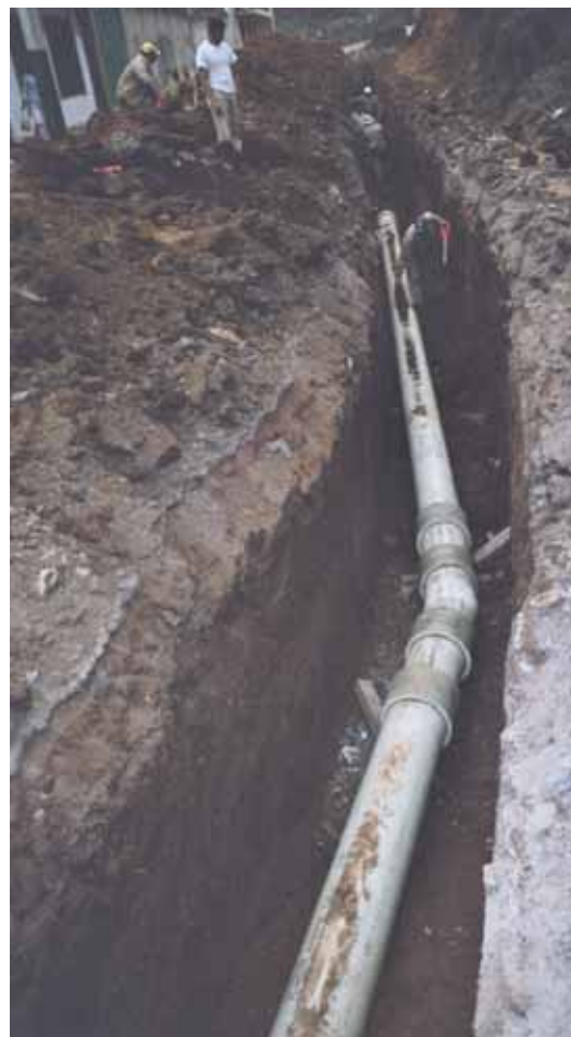
Armado de tramos cortos en codos
