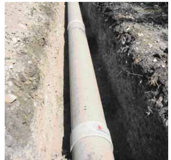
Instalación DN 600 mm
