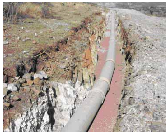
Deflexión angular tomada con los cople en DN 500 mm
