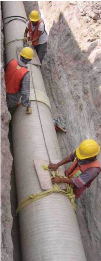
Ensamble de tubería
